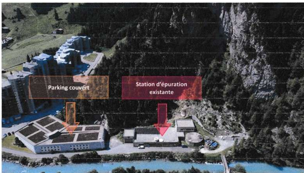
Vues aériennes du site de la station d'épuration existante (prises de vue par drone juillet 2024 - ANTEA)
