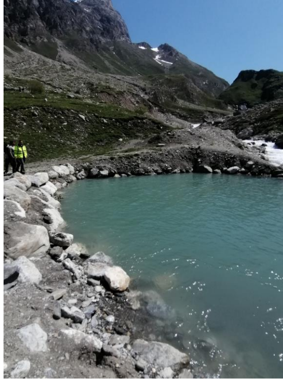
Cuvette artificielle pour la prise d'eau du captage de Pont Saint Charles
